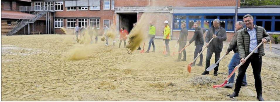
Staubige Angelegenheit: Zum ersten Spatenstich für den Anbau der Grundschule waren Vertreter von Politik und Verwaltung, der Schule und der ausführenden Firmen auf die Baustelle gekommen. Foto: Thomas Vorwerk
