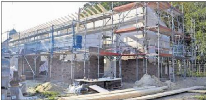
1,342 Millionen Euro teurer Neubau: Aktuell wird an der Dachkonstruktion des Kindergartens gearbeitet. Foto: Schrimper
