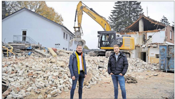
Platt gemacht: Durch den Abriss der ehemaligen Flüchtlingsunterkunft wird der Blick auf den dahinter stehenden Neubau frei. Bürgermeister Michael Fischer (links) und Bauamtsleiter Franz-Josef Rump informierten über die Abrissarbeiten. Fotos: Schrimper
