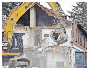
Der Bagger hatte viel zu tun: Am Dienstag war der Abriss in vollem Gange.
