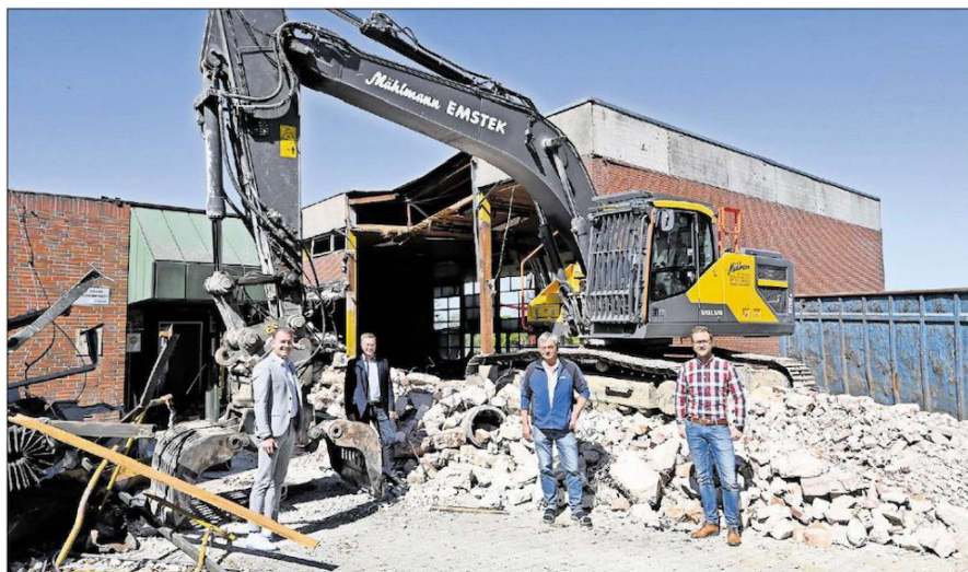
Sortenrein zerlegt: Der Abrissbagger hat bereits einen Teil der alten Sporthalle zurückgebaut. Vom Fortschritt machten sich gestern Bürgermeister Michael Fischer (von links), Erster Gemeinderat Reiner kleine Holthaus, SVE-Vorsitzender Andreas Mahlmann und Bauamtsleiter Franz-Josef Rump ein Bild.
