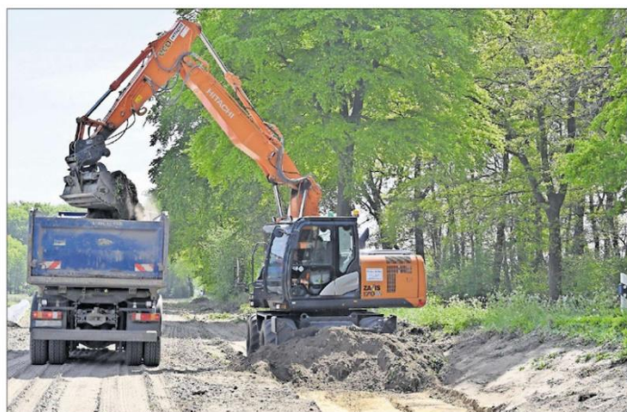
Seit dieser Woche wird gebaggert: Lkw um Lkw wird der Mutterboden ausgekoffert und die Basis für die neue Trasse wird mit gelbem Füllsand geschaffen. Foto: Thomas Vorwerk
